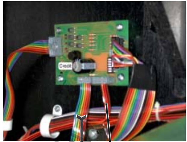
Abgezogenes Kabel vom I84 / Pulled off cable from the I84
